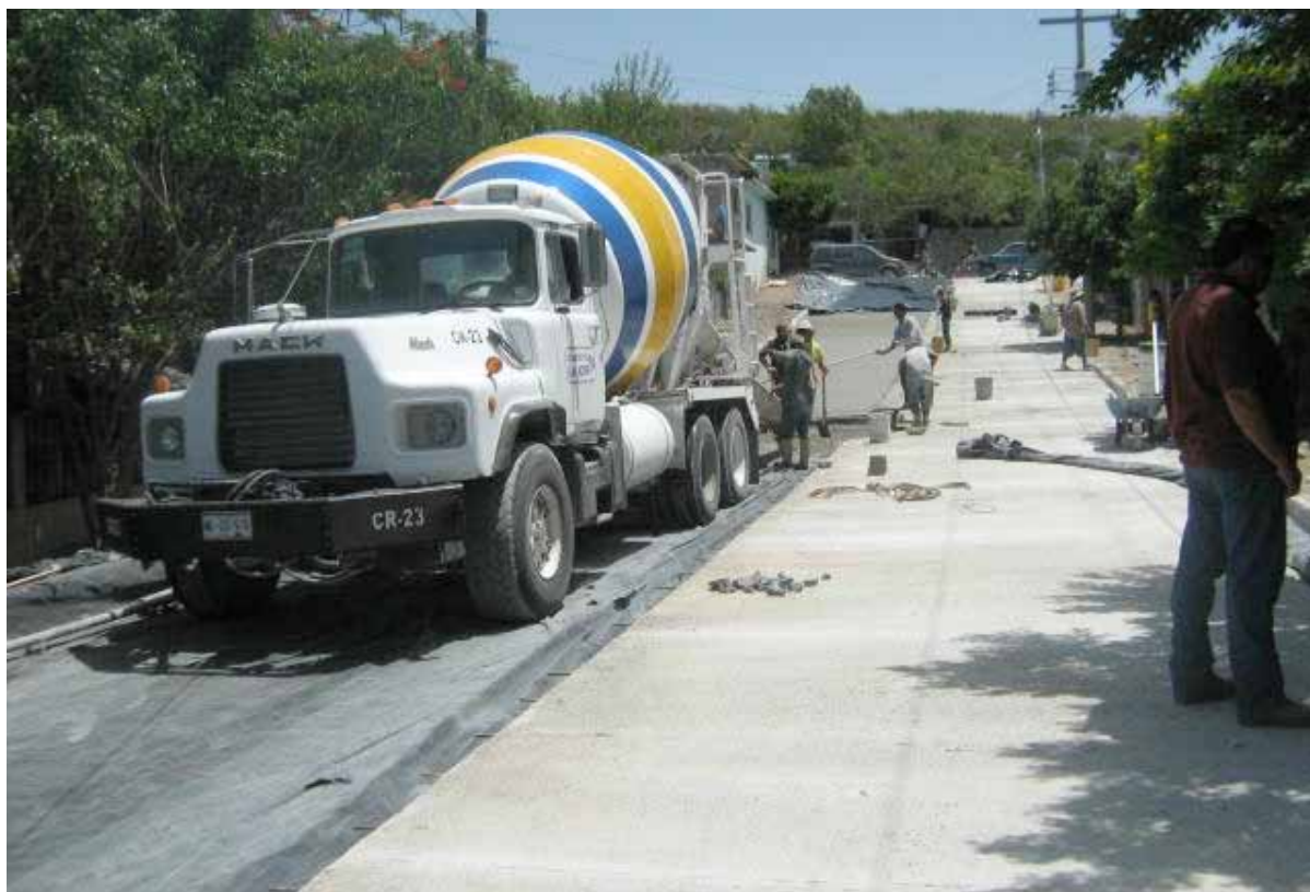
PAVIMENTACION DE CONCRETO HIDRAULICO DE FLORES DE CALLE RODRIGUEZ INURRIGARRO A CALLE MARTINEZ MANAUTOU, COL. MODERNA
