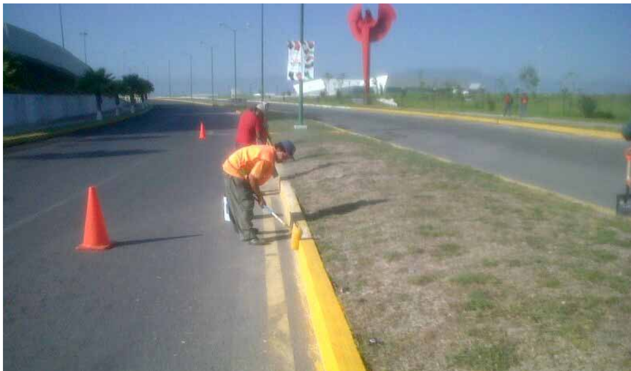
APLICACIÓN DE PINTURA DETRAFICO EN GUARNICIONES EN DIFERENTES PUNTOS DE LA CIUDAD
