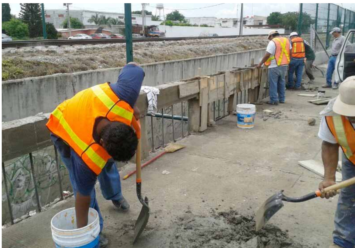
REPARACION DEL MURO DE PROTECCION DEL DRENAJE PLUVIAL EN EJE VIAL
