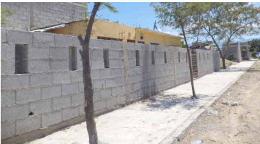
CONSTRUCCION DE BANQUETAS DE CONCRETO EN CALLE GOLONDRINAS DE AV. MEXICO A AV. LAS TORRES EN LA COL. BARRIO DE PAJARITOS
