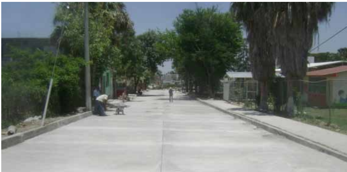
PAVIMENTACION DE CONCRETO HIDRUALICO DE CALLE ESCOLLERAS DE CALLE DEL SOL A CALLE ARRECIFES EN LA COL. EL PALMAR.
