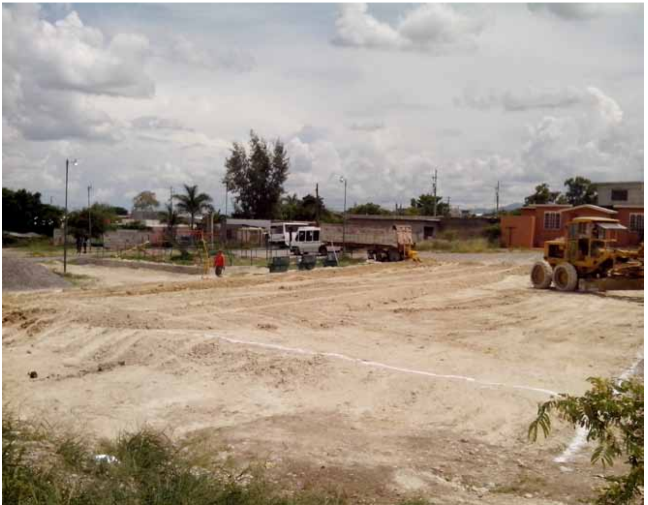
CONSTRUCCION DE ESPACIO PÚBLICO EN FRACC. AMPLIACION VILLARREAL
