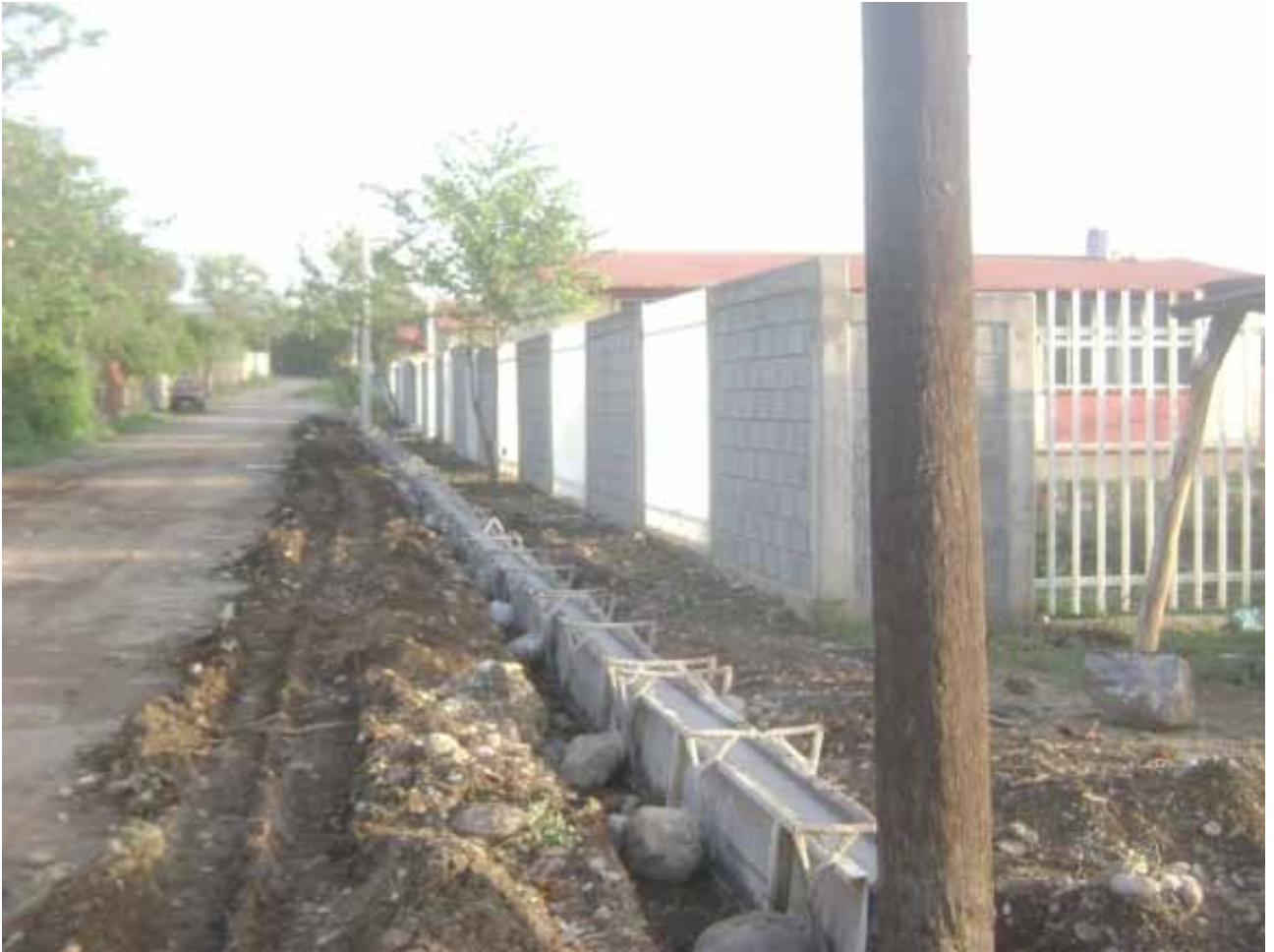
CONSTRUCCION DE GUARNICIONES EN EL EJIDO LA LIBERTAD
