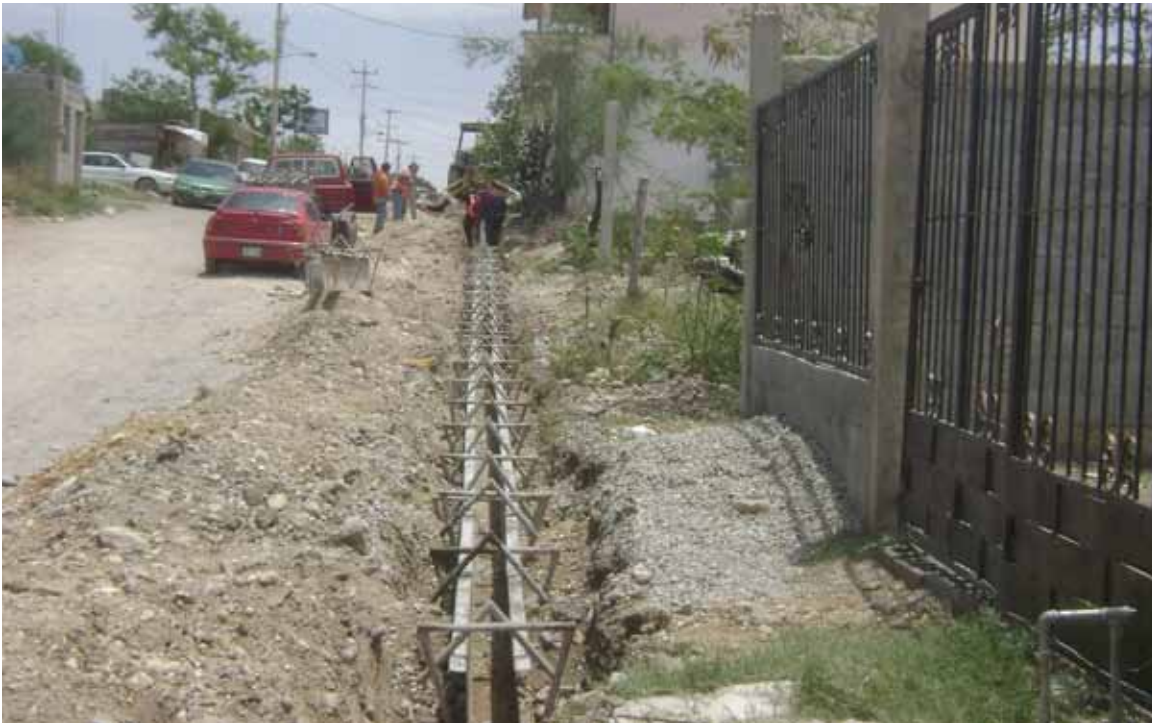
CONSTRUCCION DE GUARNICIONES DE CONCRETO DE CALLE AGRADECIMIENTO DE CALLE CAMINO A LA LIBERTAD A CALLE INTEGRACION FAMILIAR, COL. VAMOS TAMAULIPAS
