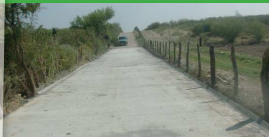
CONSTRUCCION DE VADO DE CONCRETO EN EL EJIDO ESTACION ROSA
