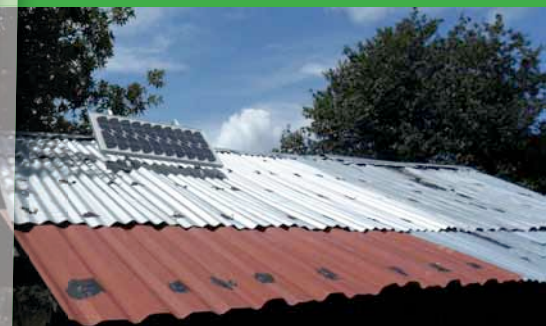
INSTALACION DE CELDAS SOLARES EN EL EJIDO EL HUIZACHAL
