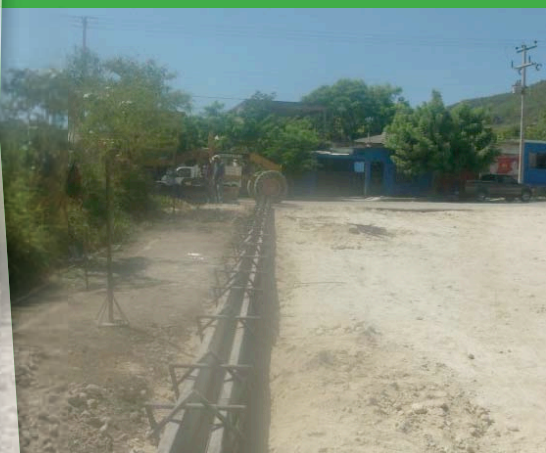
CONSTRUCCION DE GUARNICIONES DE CONCRETO DE CALLE FRESA DE CALLE FRANCISCO MEDRANO A CALLE EUCALIPTO, COL. MANUEL A. RAVIZE
