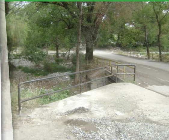
COLOCACION DE BARANDALES EN COLONIA LAS VEGAS
