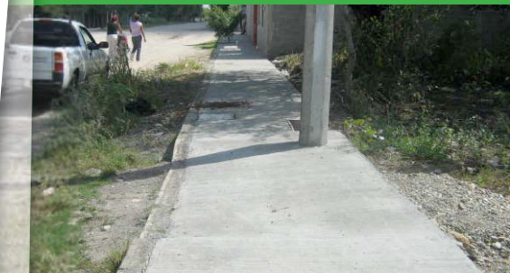
CONSTRUCCION DE BANQUETAS EN EL EJIDO EL OLIVO
