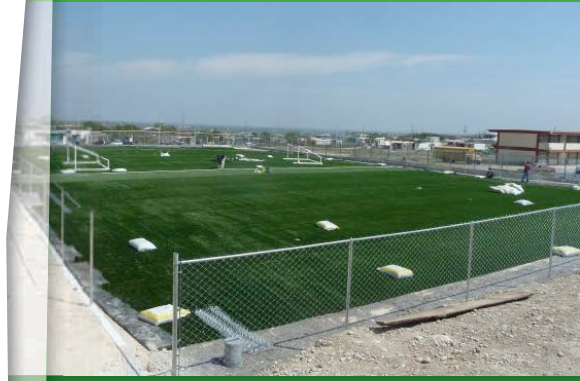
CONSTRUCCION DE UNIDAD DEPORTIVA EN COL. VAMOS TAMAULIPAS
