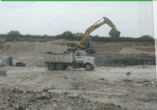
CONSTRUCCION DE CELDA NUMERO 5 DE 110 X 110 M.EN EL RELLENO SANITARIO
